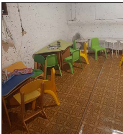
Ремонт садочку в Чернігові
